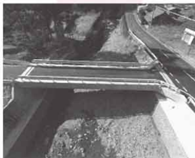
上部工架設工事及び取付道路工事
