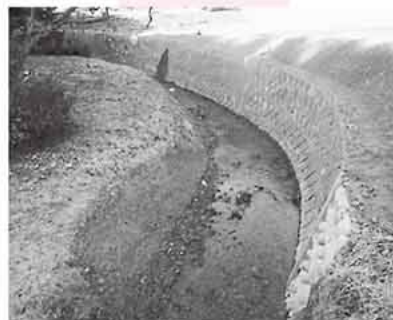
大雨で被災した護岸の 復旧工事(杉洞地内)
