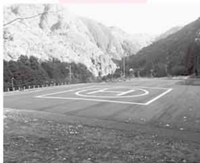
着陸場所の舗装工事(平地内)
