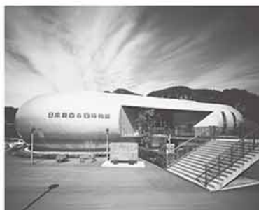
日本最古の石博物館屋根等修繕工事
