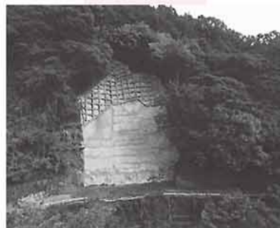
崩落土砂を防ぐための 法面補強工事(戸川地内)
