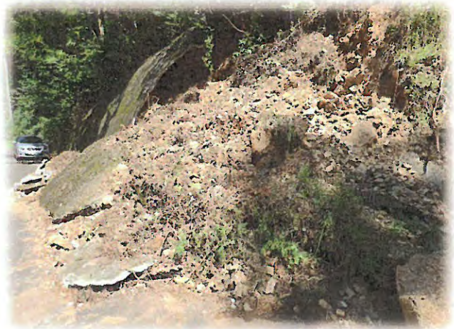
神湫財産区有林内の災害現場
