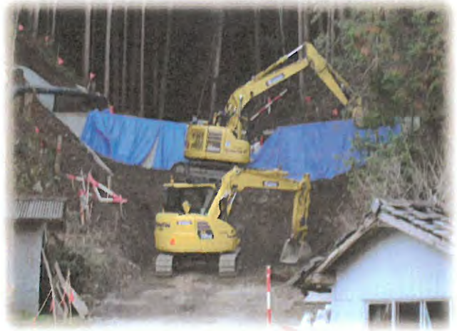
下八日市地区内の治山工事現場
