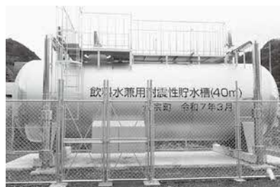
飲料水兼耐震性 貯水槽新設工事 6,630万円
