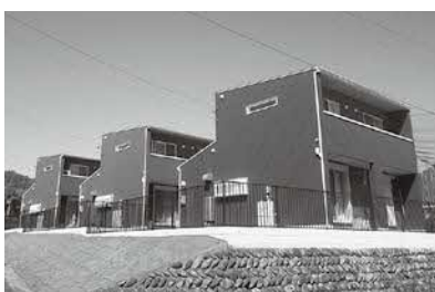
中麻生住宅 建設工事 8,927万円
