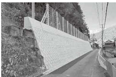
町道万場杉洞線 災害防除工事 3,310万円
