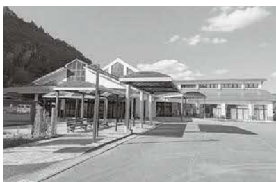
サンホーム七宗 施設改修工事 5,720万円
